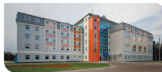
ОКРУЖНОЙ ЦЕНТР ПО ПРОФИЛАКТИКЕ И БОРЬБЕ СО СПИД И ИНФЕКЦИОННЫМИ ЗАБОЛЕВАНИЯМИ В НОЯБРЬСКЕ Введён в эксплуатацию в 2013 г.
