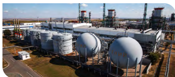
ГЕЛИЕВЫЙ ЗАВОД «ГАЗПРОМ ДОБЫЧА ОРЕНБУРГ» (ВОССТАНОВЛЕНИЕ ПОСЛЕ ТЕХНОЛОГИЧЕСКОЙ АВАРИИ) Введён в эксплуатацию в 2009 г.
